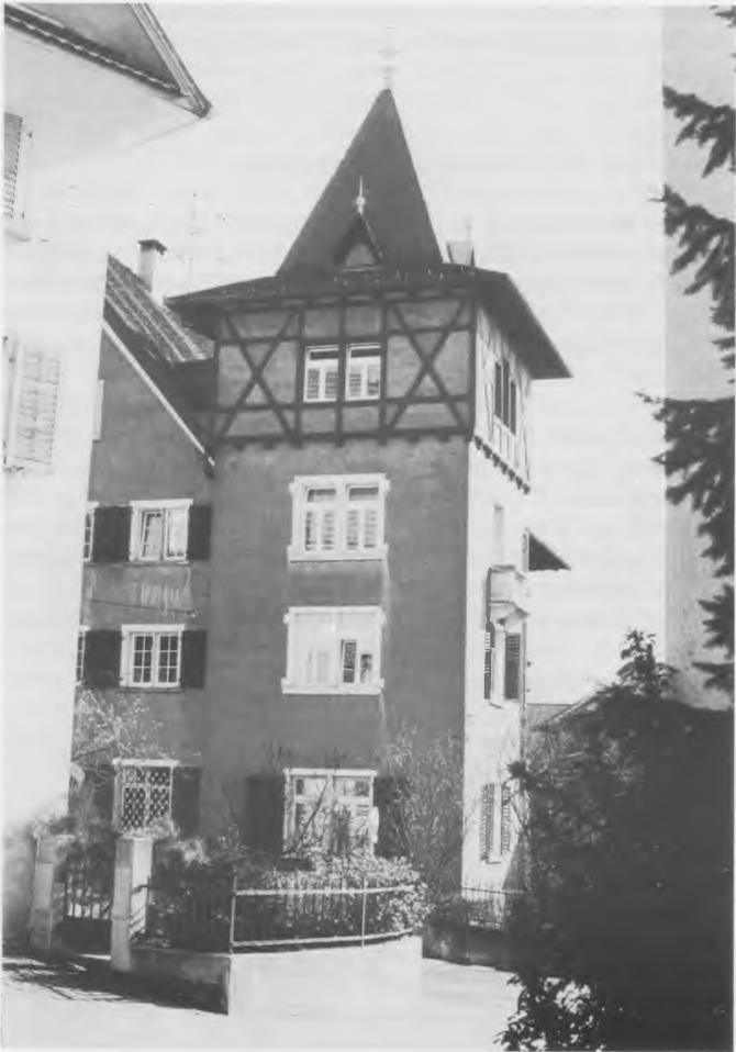
Ehemaliges Haus Gerberei Ulmer mit dem Turmanbau von Theodor Hämmerle. Aufnahme von Werner Matt 1989.
