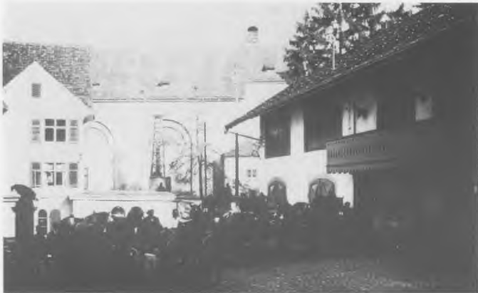
Areal F. M. Hämmerle Kirchgasse 4. Links das Stammhaus, rechts die alte Ökonomie, im Bildhintergrund vor der Kirche die längst verschwundene Transformatorenstation der Vorarlberger Kraftwerke.
