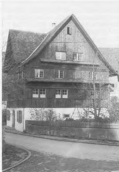
Das alte Oberdorfer Pfarrhaus an der Stelle des ehemaligen Vogthauses (Foto: Stadtarchiv)
