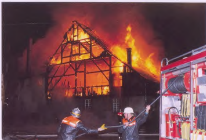
Der Vollbrand des Fabrikationsgebäudes der Waschmittelerzeugung Sonal in der Dr. Waibelstraße 4 am 1. 12. 1990 erforderte den vollen Einsatz der Wehrmänner.
