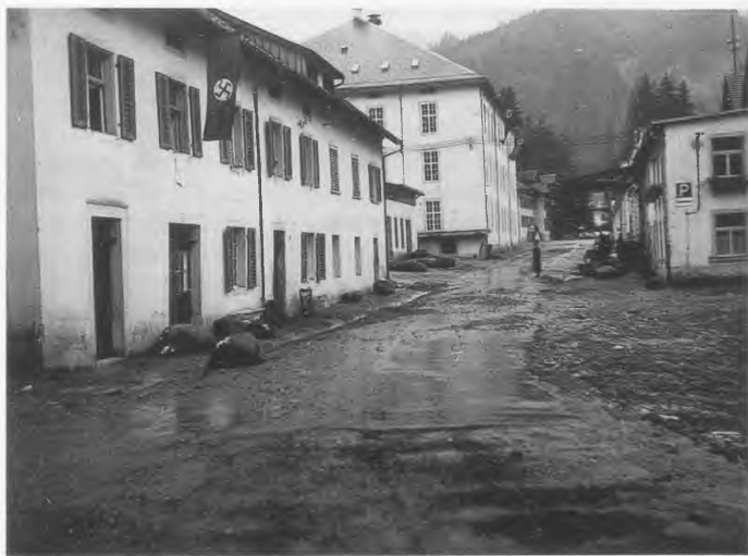
Die Freiwillige Feuerwehr Dornbirn leistete auch Wasserwehrdienst. Hier die Hochwasserschäden am 3. Juli 1940 bei der Fabrik Gütle. Foto: StAD.
