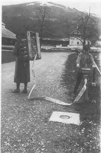
Hydrantenvorführung mit Schlauchkiste. Hier wurde demonstriert, daß die Bedienung der Hydranten „kinderleicht“ war. Foto: Freiwillige Feuerwehr Dornbirn.
