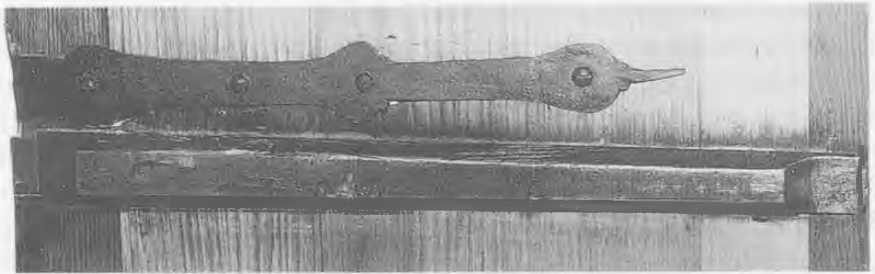
Abb. 11: Nicht bloß das schmiedeeiserne Türschloß von 1763 weist auf die sorgfältige Handwerksarbeit der Schlosser hin, sondern auch die Türbänder und die geschmiedeten Nägel weisen auf die durchgeformte Arbeit guter Schmiede-, bzw. Schlossermeister hin. Diese Einzelheiten in der Ausführung der Arbeit sollten wohl bedacht werden. Sie gehören selbstverständlich zur Gesamtheit, Schönheit und Einheit eines solchen Werkes.
