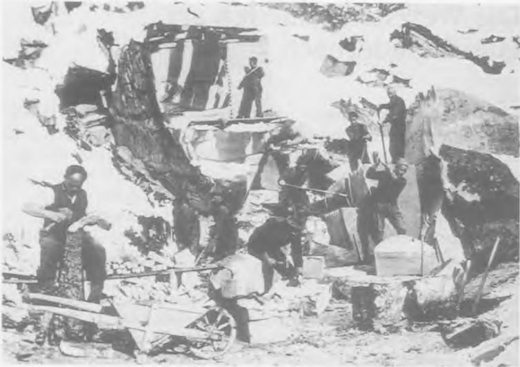
Das Bild zeigt die Arbeitsschritte in einem Schwarzacher Steinbruch vom Absprengen der großen Sandsteinblöcke bis zum Zurichten der Bröckle (vorne links) (Abb. 1).
