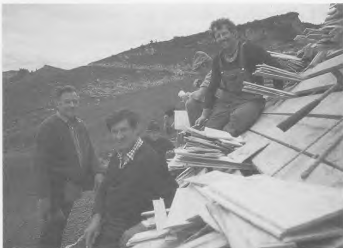
Mitglieder der Dornbirner Viehzuchtgenossenschaft bei der Renovierung der Alphütte Alten Hof (Abb. 30).
