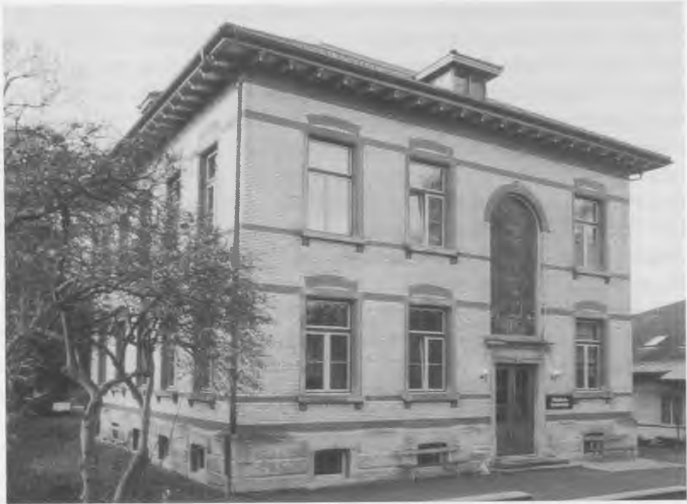
Das Gebäude der Musikschule Dornbirn in der Rosenstraße nach der Renovierung im Jahr 1988 (Abb. 48).
