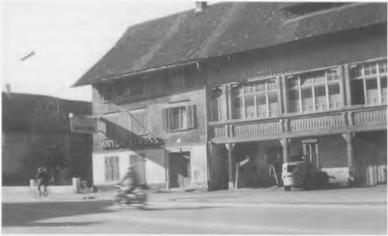
Das ehemalige Gasthaus zur Gans kurz vor dem Abbruch. (Abb. 47)
