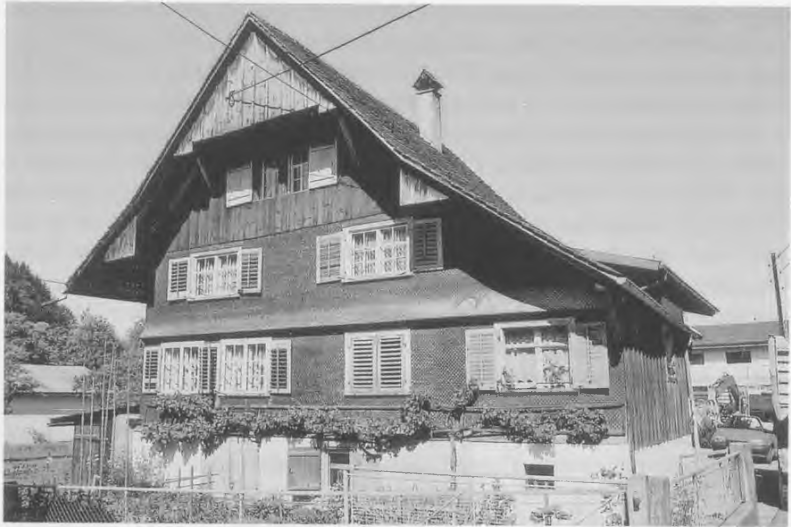
Beim Haus Gechelbachgasse 12 zweigte der Weg zur „Achmühle“ ab. (Abb. 3)
