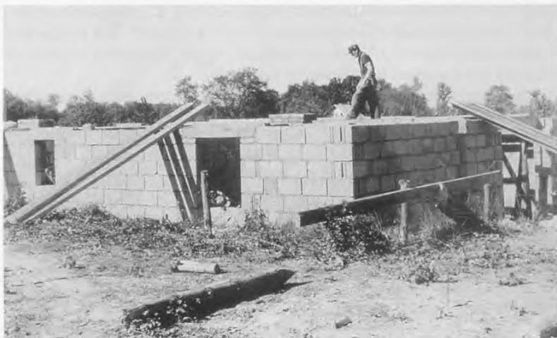
Arbeiten an einem Rohbau, 1957. (Abb. 4)
