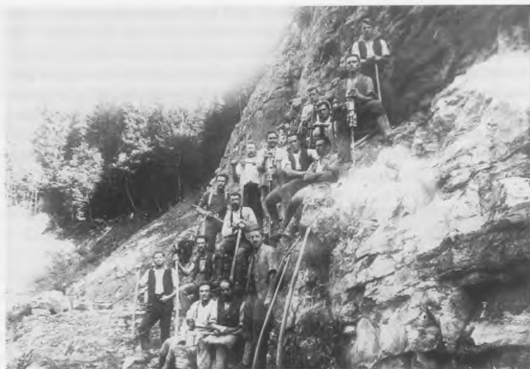
Arbeiter beim Straßenbau in den 1920er Jahren. (Abb. 4)
