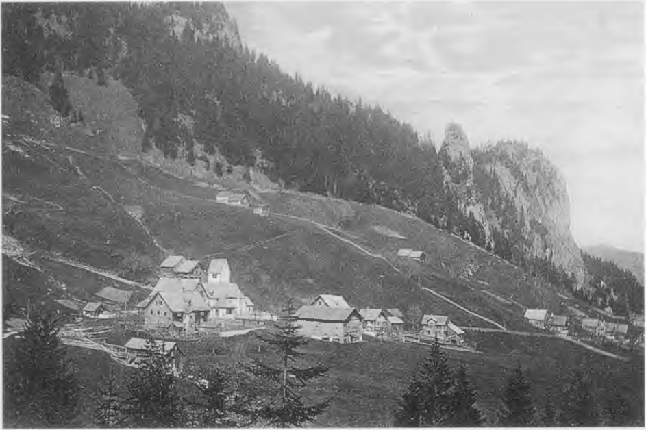
Alter Dorfkern (Abb. 5): Gebäudeensemble aus der Zeit vor dem Kirchenbrand von 1927. Rechts von der Kirche ist die Säge erkennbar, wo die Brandkatastrophe ihren Ausgang nahm. Um 1910.
