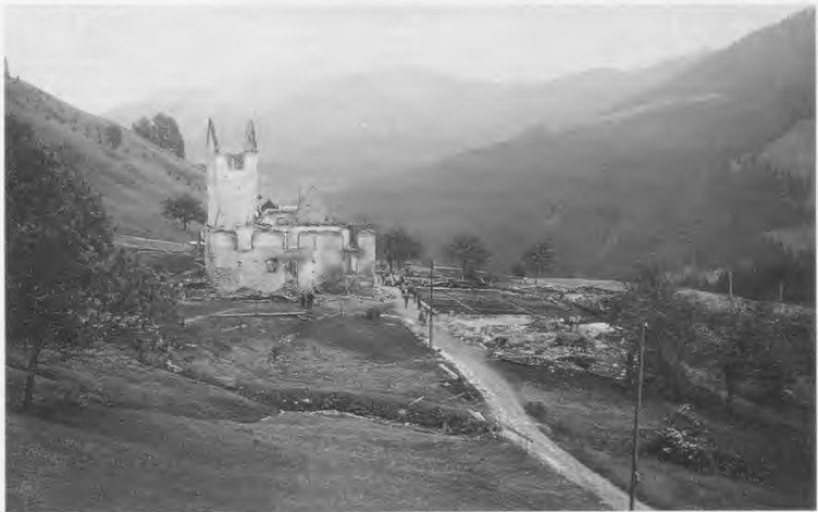
Dorfzentrum nach dem Großbrand. (Abb. 2)
