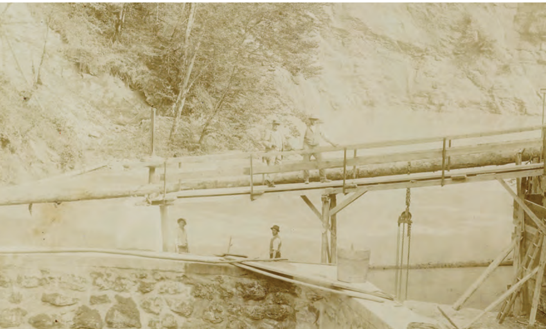
Abb. 60: Bau der Staumauer des Staufensees um 1898
