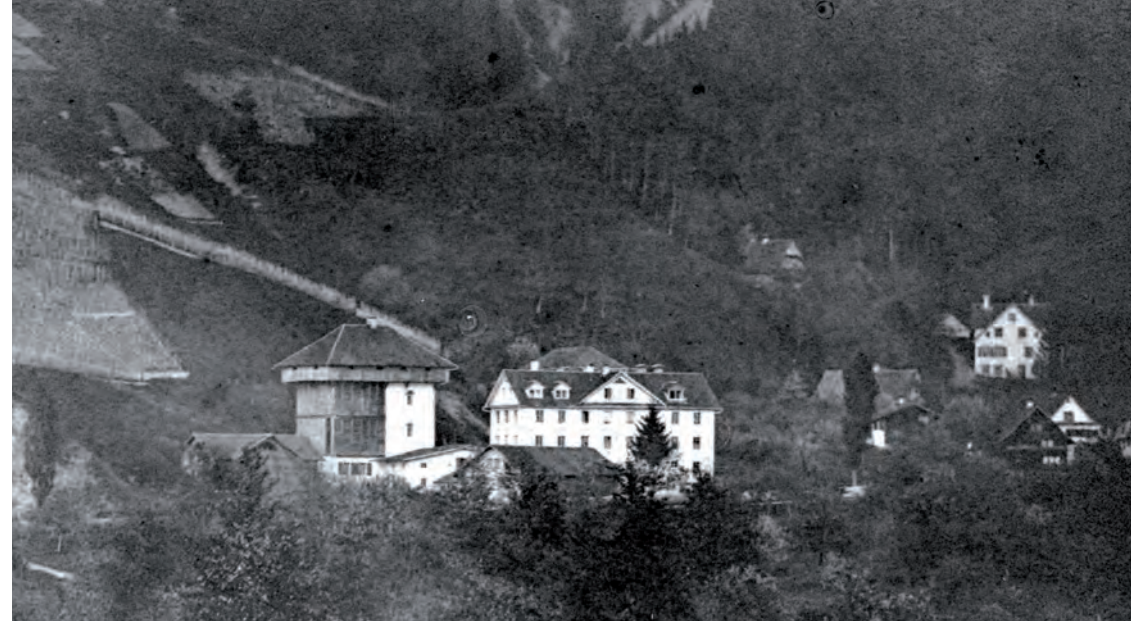
Abb. 26: Die Fabrik Eulental vor dem Umbau 1868
