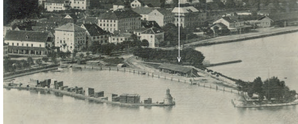
Abb. 17: Die Zollabfertigungshalle am Bregenzer Hafen
