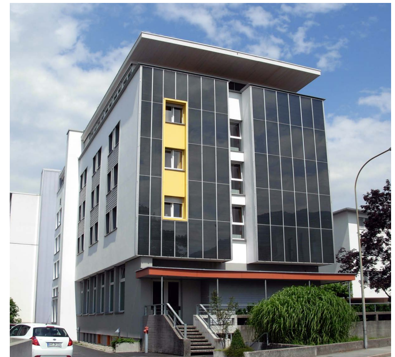
Abb. 27 Die Fassade des Kolpinghauses wird für eine Solaranlage genutzt
