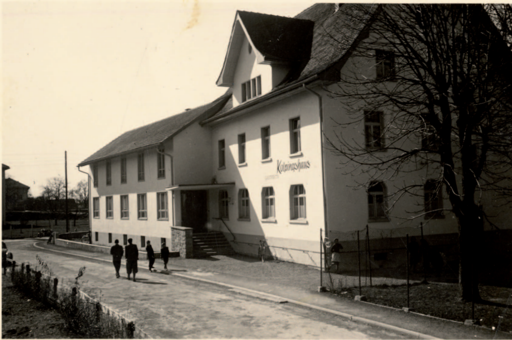
Abb. 23 Das Kolpinghaus mit dem 1953/54 errichteten Anbau
