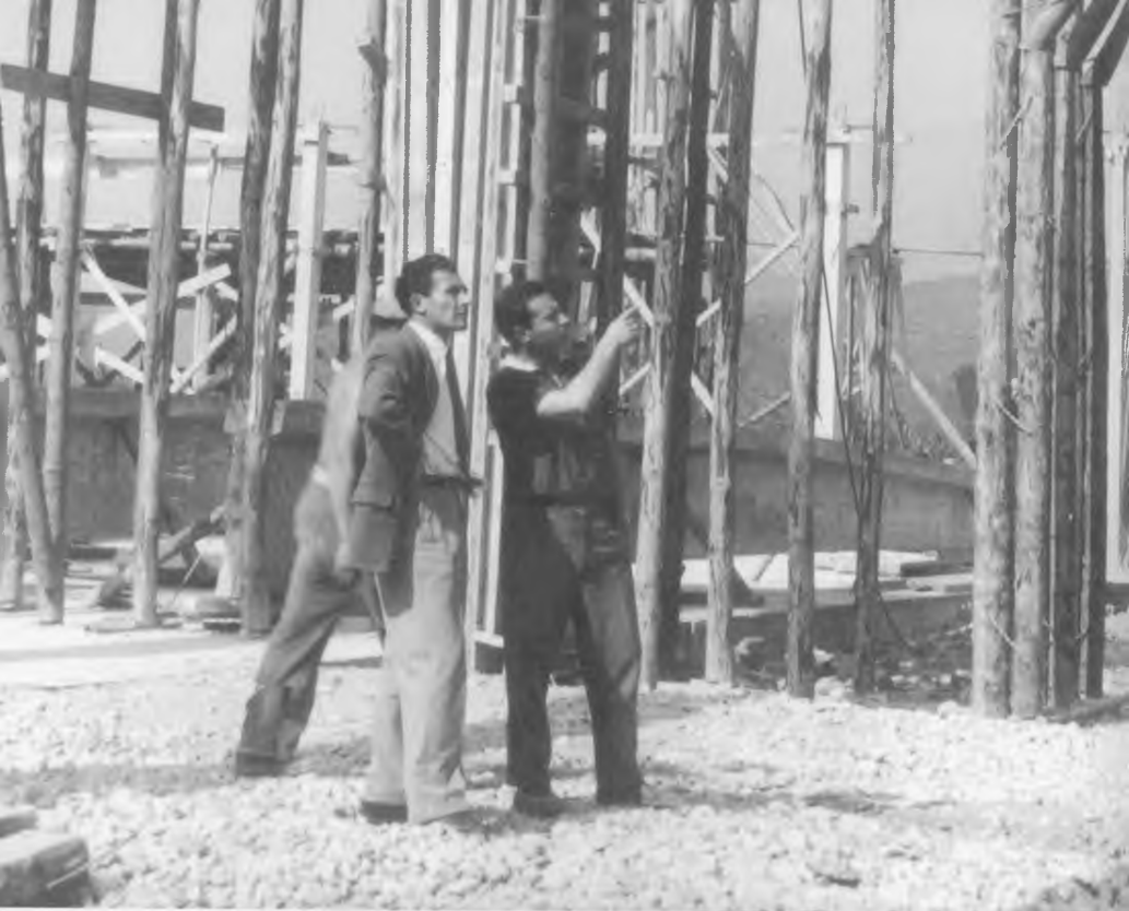
Dipl.-Ing. Heinz Hämmerle informiert sich über den Baufortschritt beim Betriebsneubau der Veredlungshalle I in Fischbach, 1955
