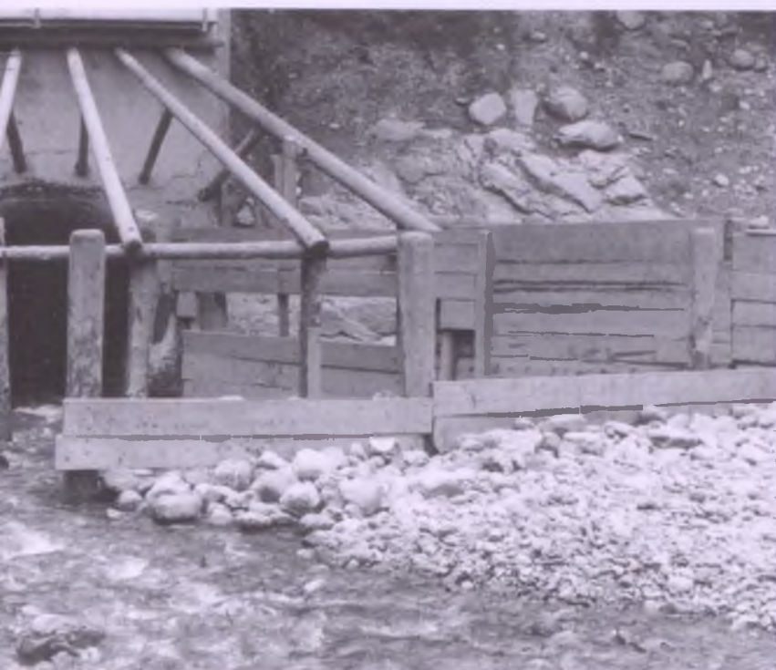
Tunnelschleuse nach der Entschotterung 1979
