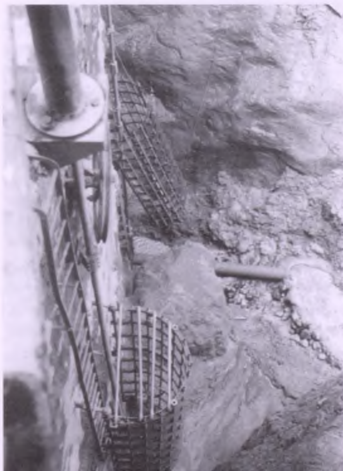
Sanierung Staufensee 1968-80 Links Fallenschutzkörbe
