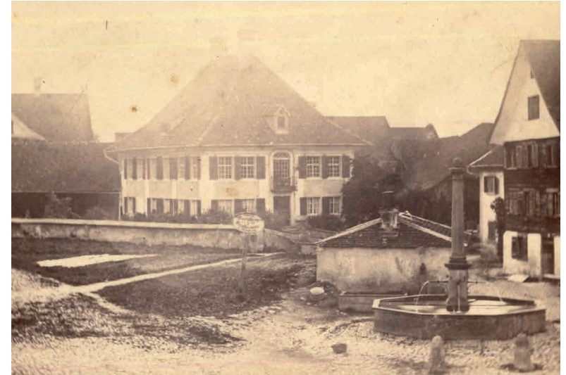
Der alte 1766 erbaute Pfarrhof bei St. Martin in Dornbirn mit dem für die Zeit charakteristischen Walmdach, 1860er Jahre
