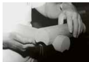
Abb. 48: Verbindung von Rundholzprofilen
