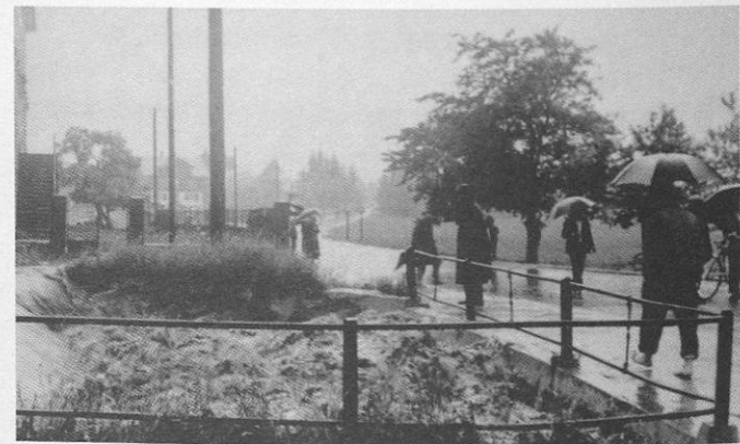
Hochwasser am Fischbach, bei FM Hämmerle, 16.06.1937
