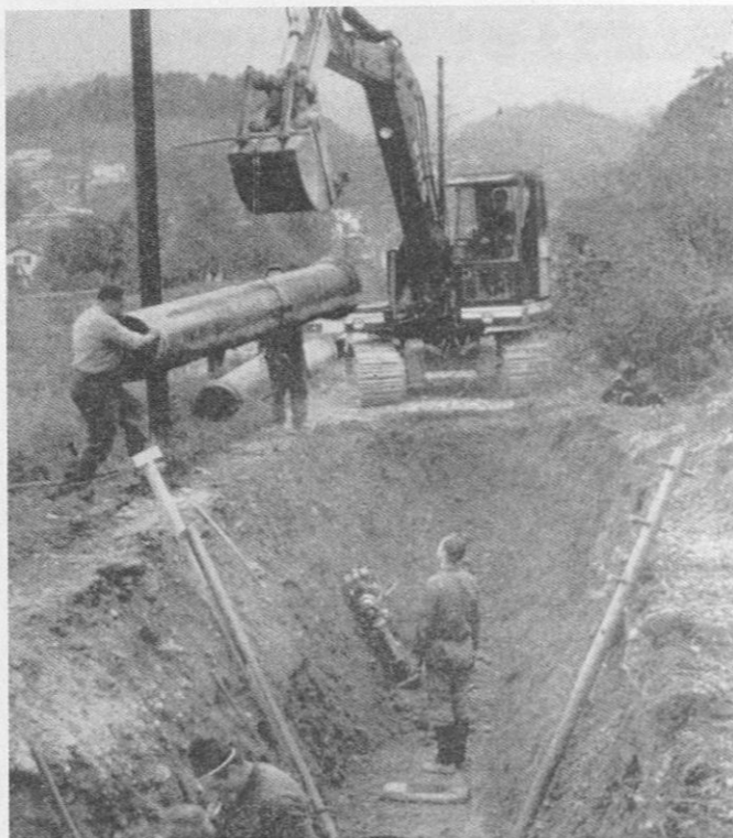
Verlegung von Wasserrohren
