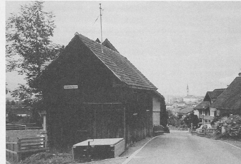
Ein noch bestehender Umleitungsschacht
