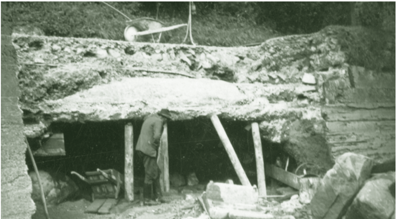
Wasserefassung der Bodenfabrik im Gütle, abgesunkener Kanal unter der Straße - 1939
