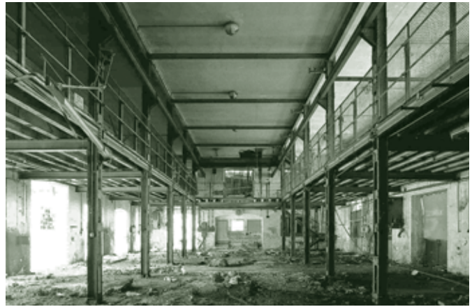
Umbau der Dreherei um 2000 - heutiger Eingangsbereich der inatura
