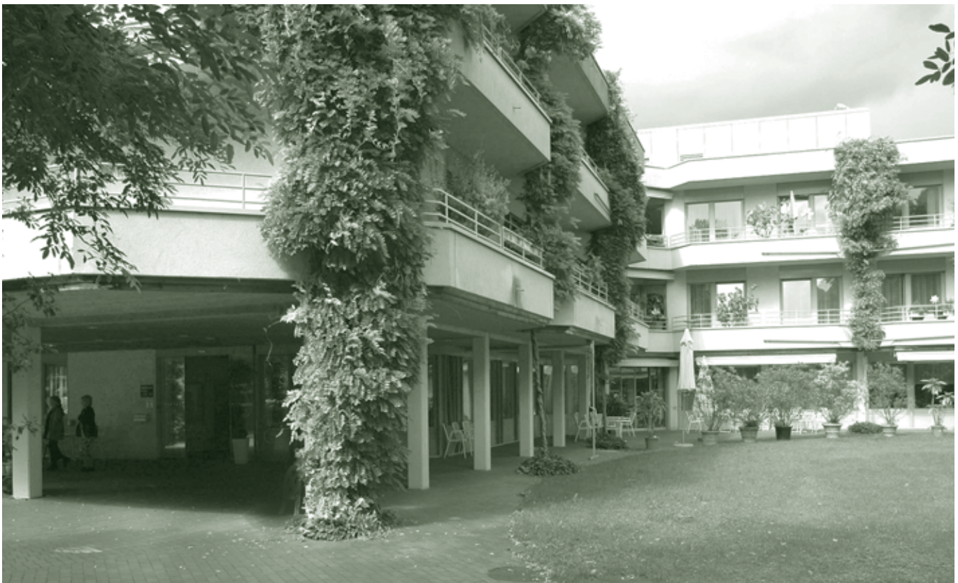
Ehemaliges Pflegeheim an der Lustenauerstraße
