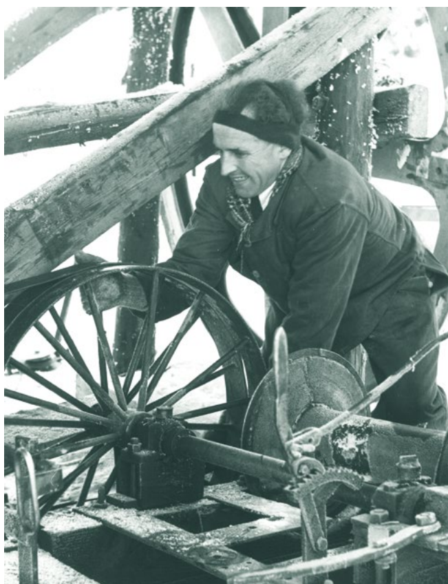
Ein letzter prüfender Blick | Foto: Doppelmayr Seilbahnen GmbH
