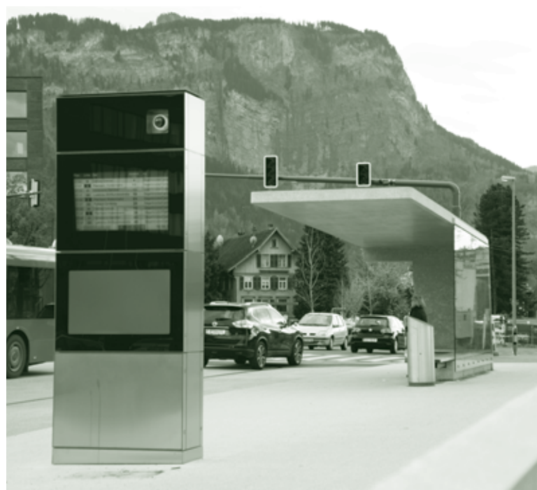
Bushaltestelle auf der Sägerbrücke
