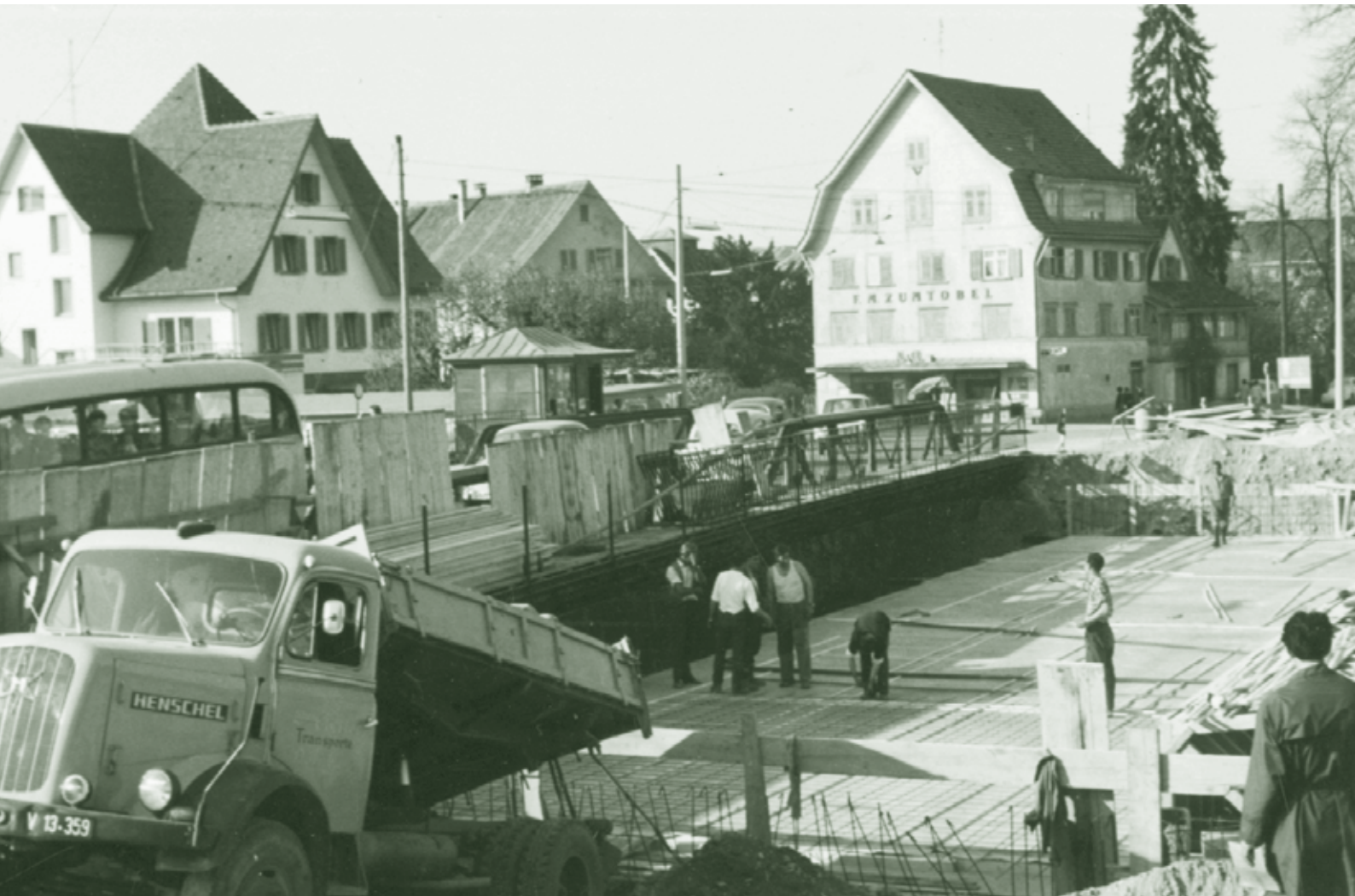
Bau der Sägerbrücke in den 1960er Jahren
