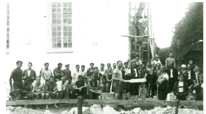
Renovierung der Kapelle Kehlen
