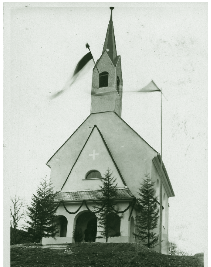
Kapelle Oberfallenberg nach der Renovierung um 1930
