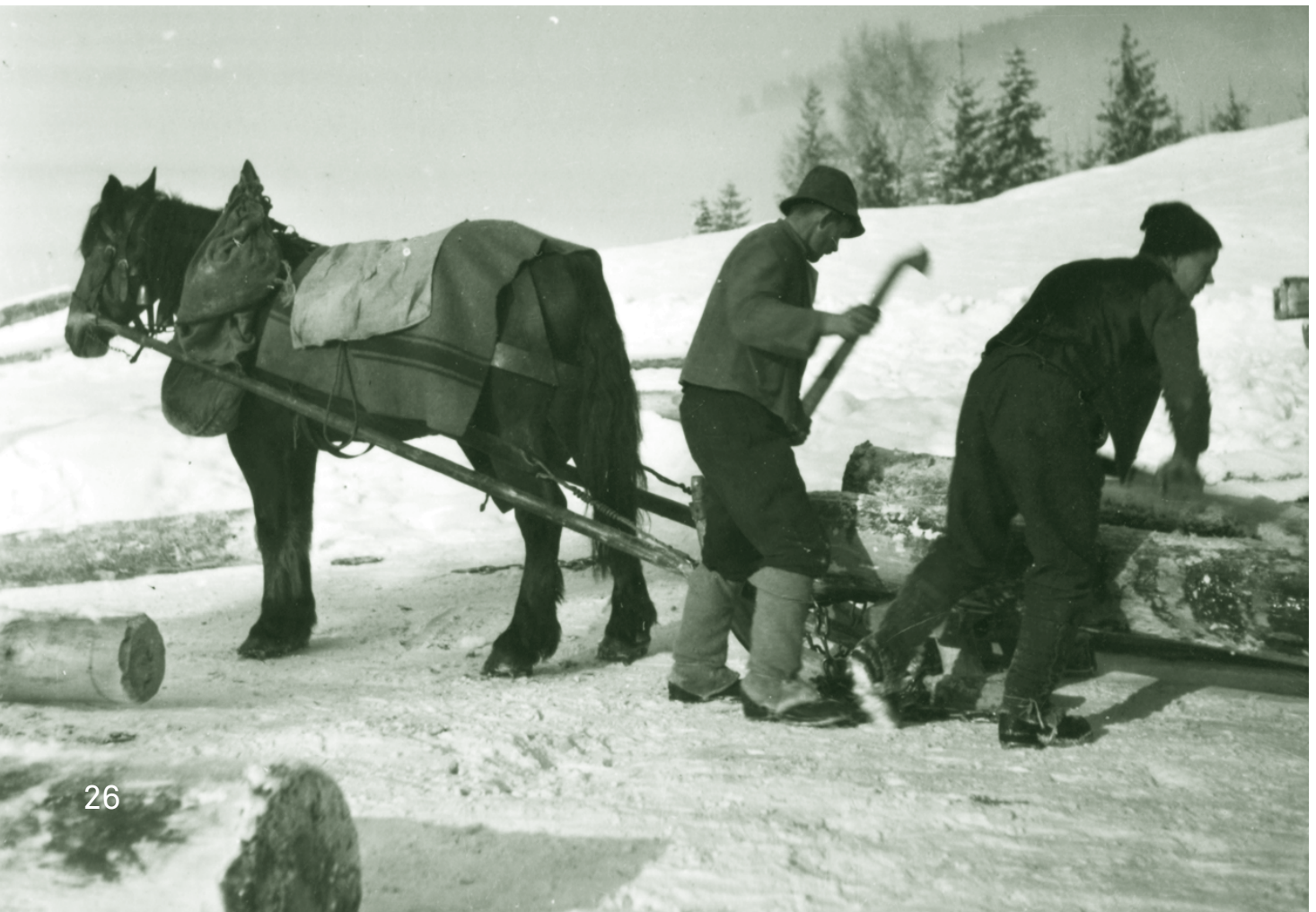
Holzarbeiten, ca. 1950er-Jahre
