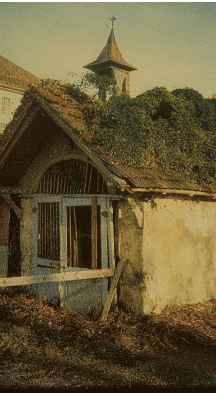
Die alte Kapelle Sägen vor Abbruch
