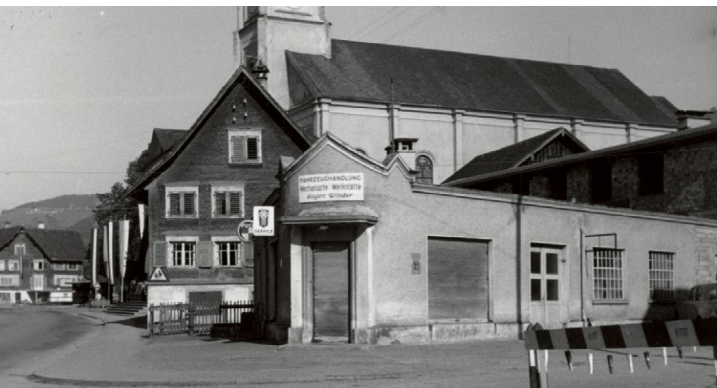
Das Geschäft Fahrzeughandlung Eugen Winder in der Hatlerstraße vor dem Umbau
