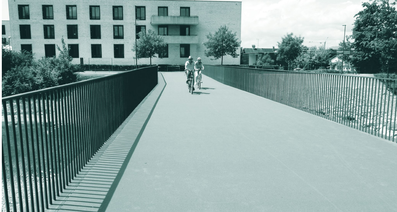
Die neue Radwegebrücke Birkenwiese | Foto: Stadt Dornbirn
